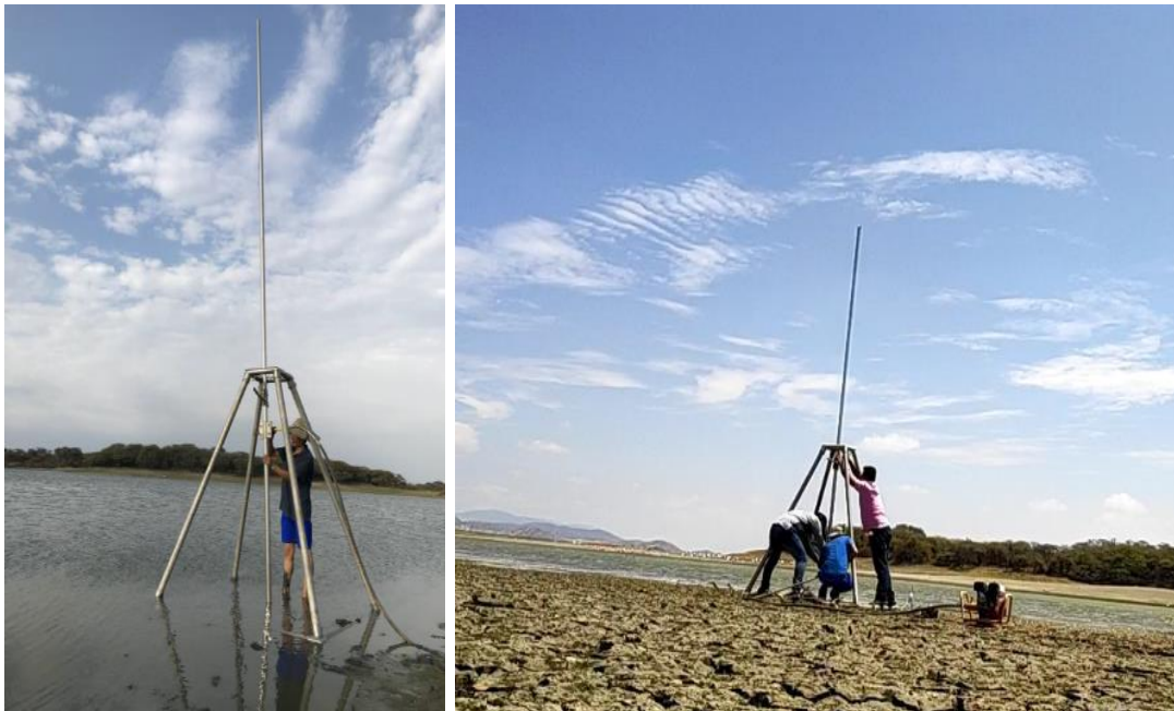
Figura 3. A la izquierda ensamblado de la estructura trapezoidal para introducción de tubo de acero. A la derecha introducción del núcleo de sedimentos
