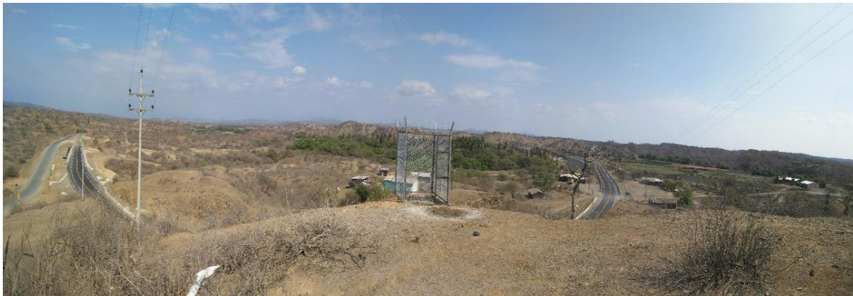
Figura 1. Construcción de la estación Meteorológica Riomar, Sullana, Piura.
